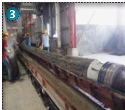
Pengecoran Beton dan Penutupan Cetakan
