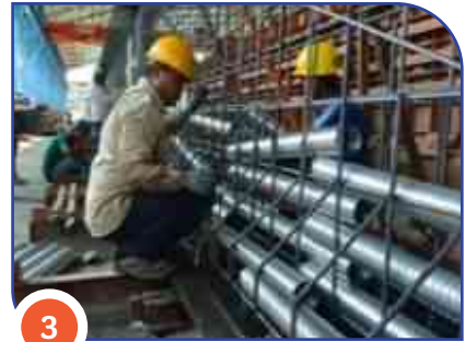
Pemasangan Tulangan atau Selongsong Installation of reinforcement or sleeves
