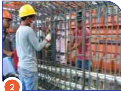
Perakitan Tulangan atau Selongsong Assembly of reinforcement or sleeves
