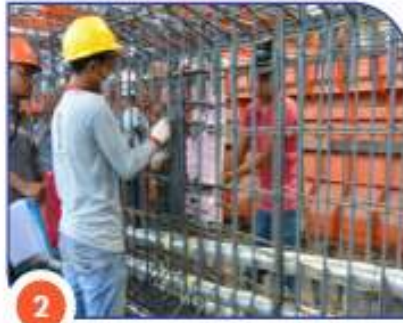
Perakitan Tulangan atau Selongsong Assembly of reinforcement or sleeves
