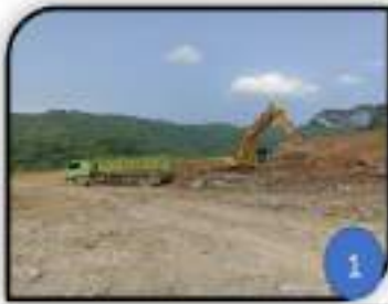
1 Land Clearing (Kupas Daur Bundan/ OJ Atau Tanah penutup)
