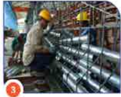
3 Pemasangan Tulangan atau Selongsong Installation of reinforcement or sleeves
