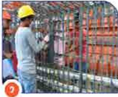
2 Perakitan Tulangan atau selongsong Assembly of reinforcement or sleeves
