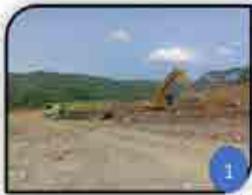
1 Land Clearing (Kubas Over Burden/ OB Atau Tanah penutup)
