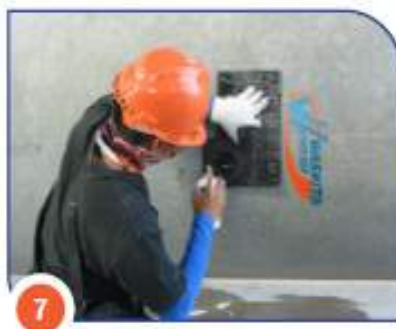
7 Pengeluaran Produk Beton Production of Concrete Product
