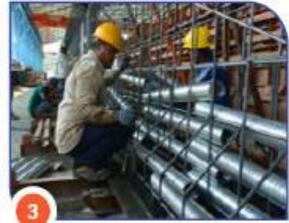
Pemasangan Tulangan atau Selongsong Installation of reinforcement or sleeves
