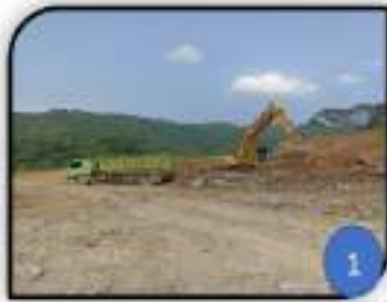
1 Land Clearing (Kupas Diker Bundan/ Oj Atau Tanah penutup)
