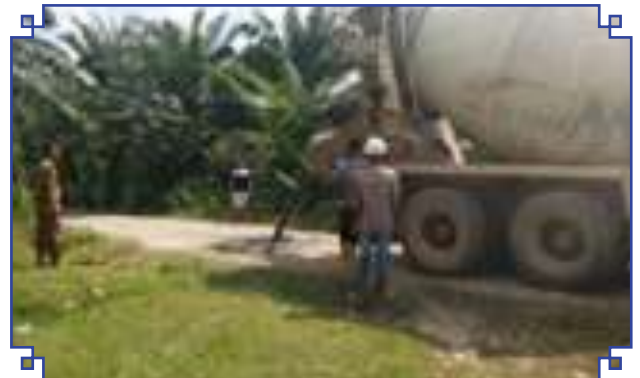
Perbaikan Jalan Umum di Palembang, Sumatra Selatan Kegiatan CSR yang dilakukan adalah pengecoran jalan akses umum di daerah Pangkalan Balai, Pulau Harapan, Sumatra Selatan Public Road Repair in Palembang, South Sumatra The casting of public access road in Pangkalan Balai area, Harapan Island, South Sumatra
