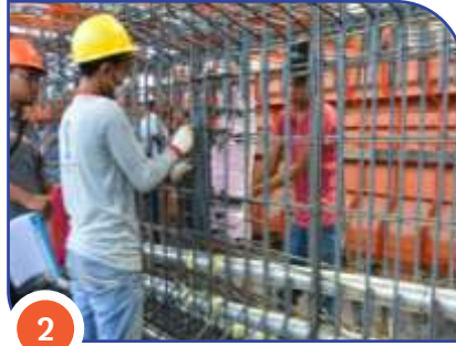
Perakitan Tulangan atau Selonsong Assembly of reinforcement or sleeves
