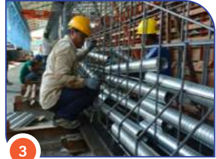
Pemasangan Tulangan atau Selonsong Installation of reinforcement or sleeves
